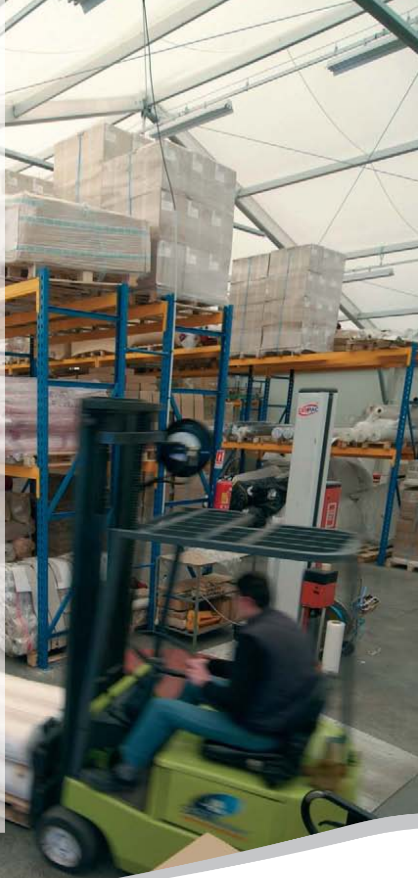
Estructura básica de almacenaje con cubierta térmica y revestimiento exterior en panel sándwich para un mejor aislamiento
