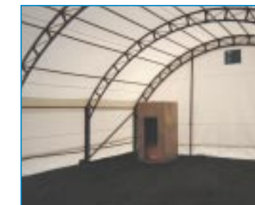
Temps 0 : démarrage du foyer.
